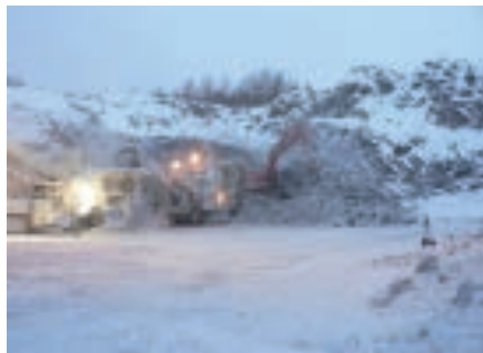
Kuva 1a. Tilanne louhoksessa murskauksen aikana ns. paljaalla silmällä tarkasteltuna
