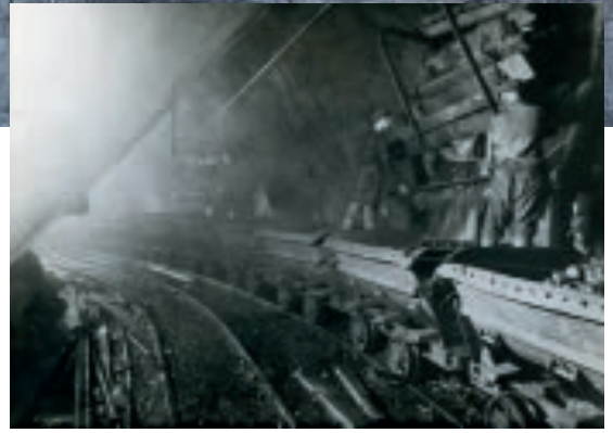
Kuva 3: Malmisiiloista malmi lastattiin junavaunuihin lastausrännien kautta.
