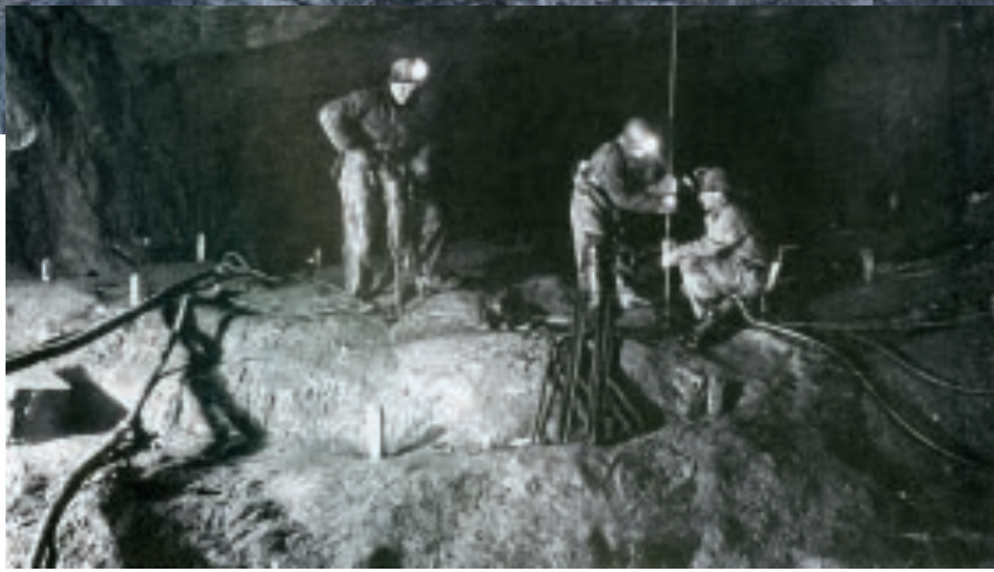
Kuva 2: Ensimmäiset jatkotankokalustot tehtiin itse. Jatkotankoporaus tapahtui alaspäin. Poratankojen nostossa ja käsittelyssä tarvittiin miesvoimaa.
