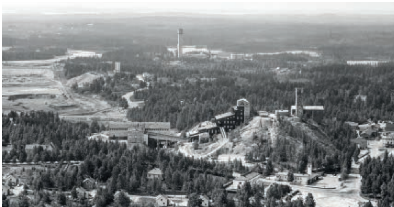
Outokummun kaivoksen kolme nostotornia: Etuoikealla Vanhan kaivoksen torni sekä vanha rinnerikastamo ja suuri rikastevarastohalli, takana keskellä korkea Keretin nostotorni ja keskimmäisenä vasemmalla matalabko Mökkivaaran nostotorni.
