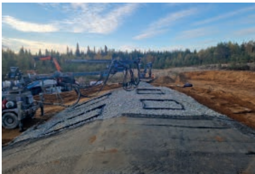
Koerakenteessa testataan sivukiven peittomateriaalina beliittisementtiä, jonka valmistuksessa on hyödynnetty metsäteollisuudessa syntyvää soodasakkaa ja lentotuhkaa. Vaihtoehtoisilla materiaaleilla pyritään korvaamaan peittorakenteissa yleisesti käytettyjä kalvorakenteita.
